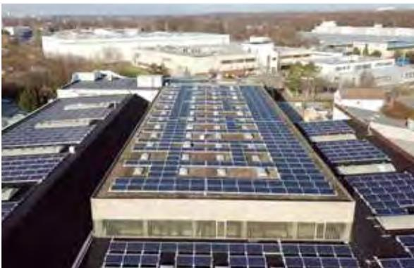
Um dem Klimawandel entgegen zu wirken haben wir 2018 eine Photovoltaik-Anlage auf das Dach unseres aks-Firmsitzes in Troisdorf installieren lassen und in Betrieb genommen. 1.286 m<sup>2</sup> Gesamtfläche an Solarmodulen erzeugen 196.836 kWh, davon speisen wir über die Hälfte ins öffentliche Netz ein (und vermeiden so 118 Tonnen CO<sub>2</sub> pro Jahr).
